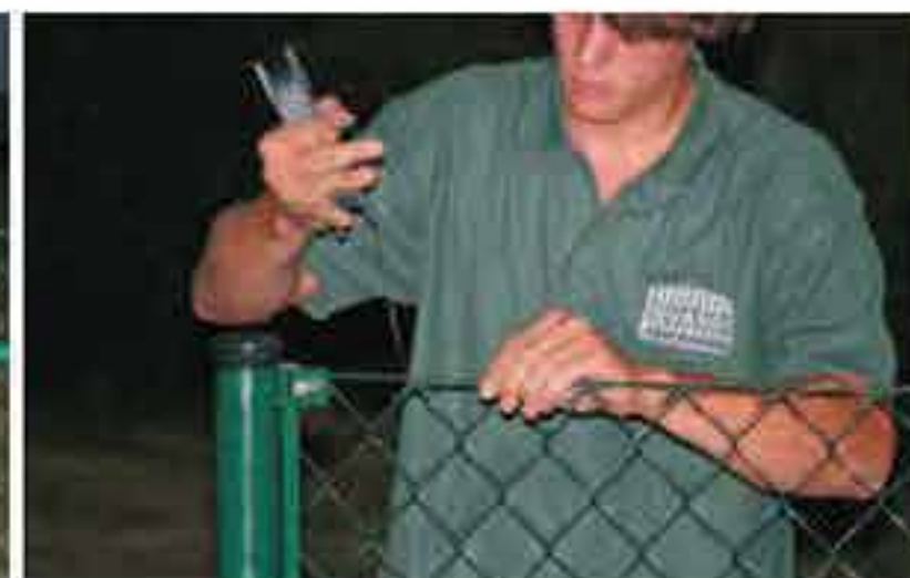
Mittels Nähn Draht das Geflecht an den Spanndrähten festwickeln.
